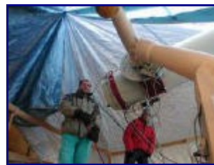
Fig.5 Tout est recouvert
